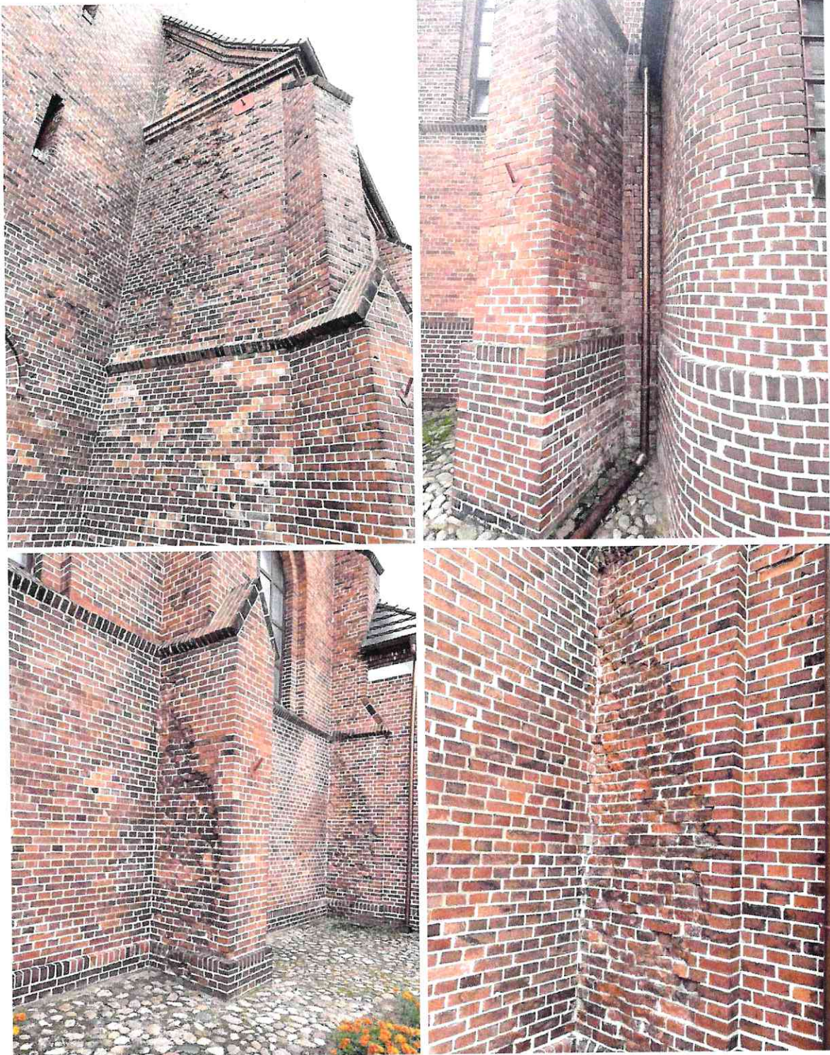
Stan zachowania elewacji (zbliżenie przypór) wrzesień 2020 roku, źródło: ks. Wojtek Jurek
